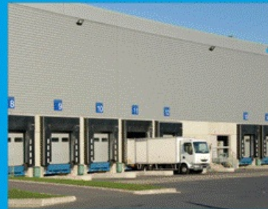
4. AMB Gonesse Distribution Center 2 Roissy Charles De Gaulle Airport, Paris
